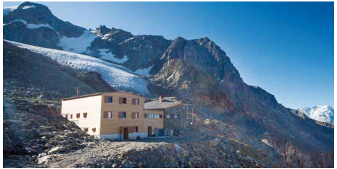
Bei Anbau und Renovation der Domhütte auf 2940 m.ü.M. war die Firma Yesotec als Generalunternehmer im Einsatz.
